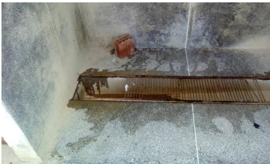
Figura 19 – Canaleta permite entrada de vetores no abrigo (Hospital Regional de Salgueiro)
